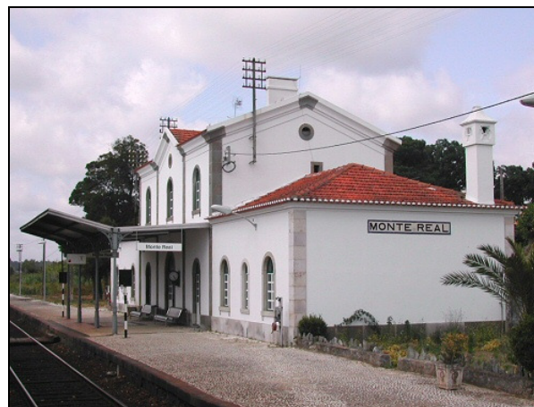
Linha do Oeste - Edifício Principal da estação de Monte Real
