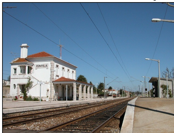
Linha do Oeste – Edifício principal e cais secundário da estação da Fontela
