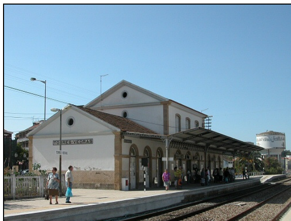
Edifício Principal e cais de embarque vistos do lado Sul
