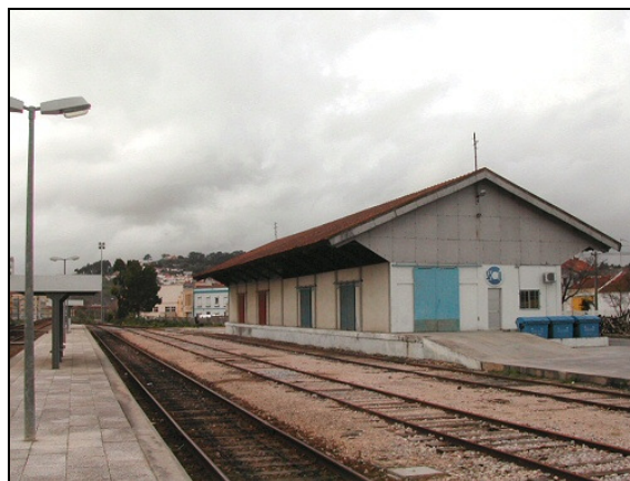
Antigo armazém de carga (actual armazém da SECIL)
