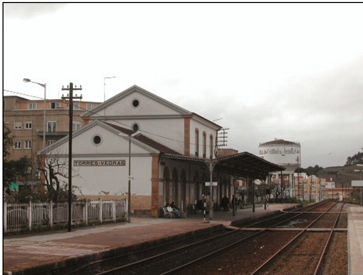
Edifício Principal e cais de embarque antes das obras de beneficiação
