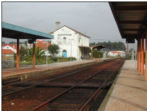
Edifício Principal e cais de embarque antes da beneficiação de 2004
