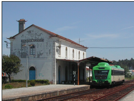
Automotora 0366 à chegada com um Regional Figueira da Foz -> Caldas da Rainha
