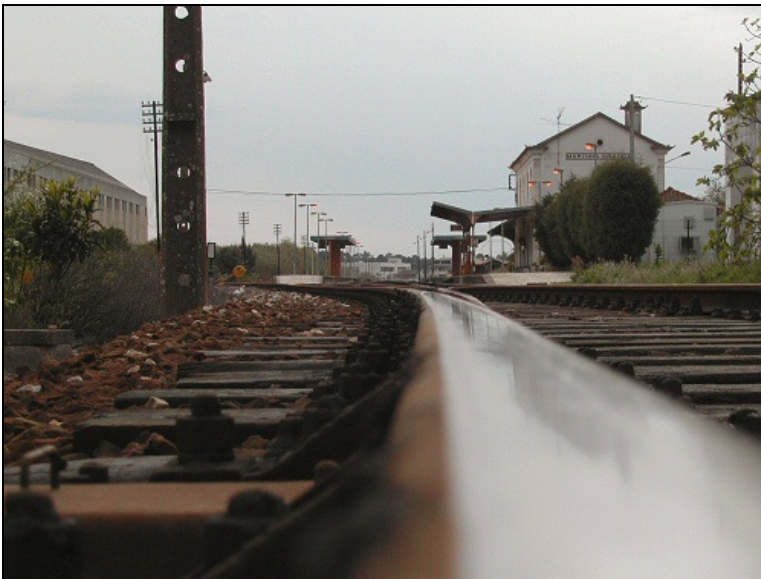
Entrada do lado Norte da estação da Marinha Grande
